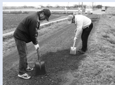
▲農道の路面補修
