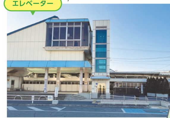
▲整備イメージ 白岡駅東口エレベーター
