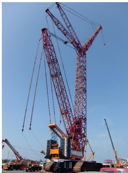
1,250t吊大型クレーン
