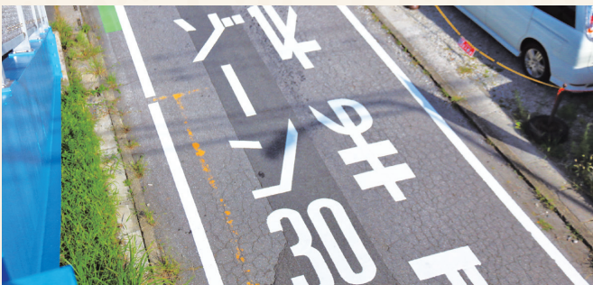
ゾーン 30 道路標示等設置事業
