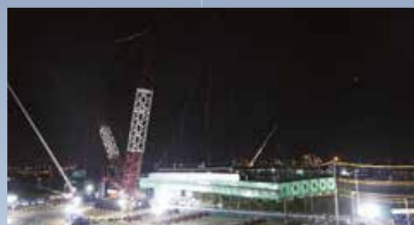
② 周辺の道路を通行止めにし、橋桁を吊り上げます。
