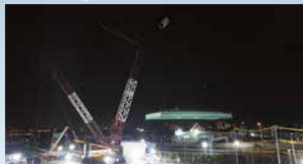
③ クレーンを旋回させ、吊るした橋桁を所定の位置に持っていきます。
