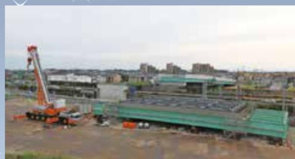
① 事前にクレーンで吊り上げる橋桁を組み立てておきます。
