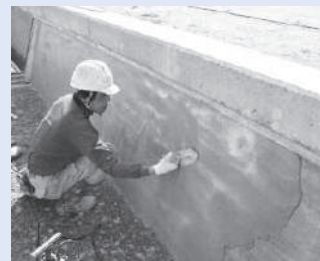
▲老朽化した水路壁のコーティング
