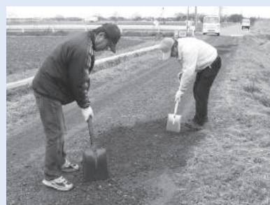
▲農道の路面補修
