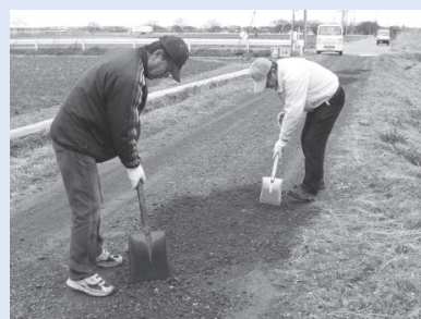
▲農道の路面補修
