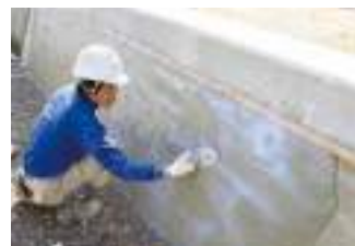
▲老朽化した水路壁のコーティング
