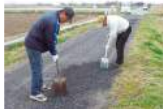
▲農道の路面補修
