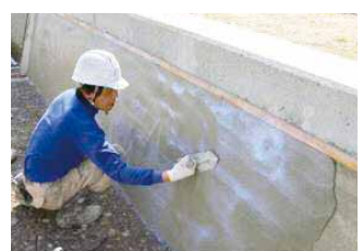
▲老朽化した水路壁のコーティング
