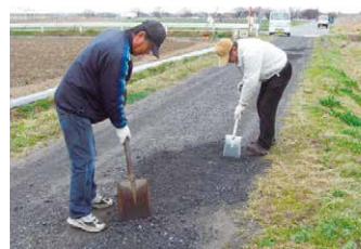
▲農道の路面補修
