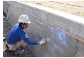
▲老朽化した水路壁のコーティング
