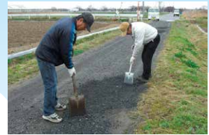
▲農道の路面補修
