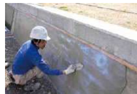
▲老朽化した水路壁のコーティング
