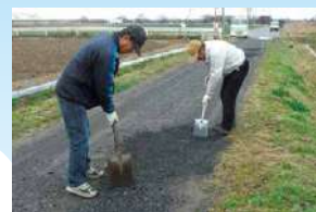
▲農道の路面補修
