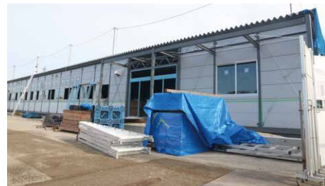
※建設中の仮設本庁舎です。
