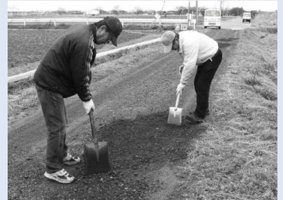
▲農道の路面補修
