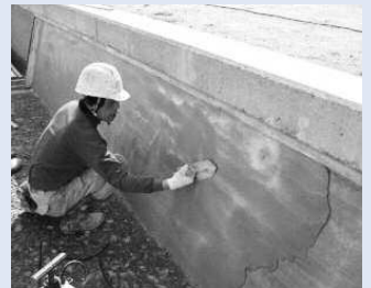
▲老朽化した水路壁のコーティング
