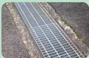
道路脇の側溝蓋 (グレーチング)
