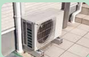
エアコン室外機
