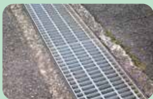
道路脇の側溝蓋 (グレーチング)
