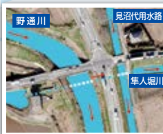
1 野通川・隼人堀川の立体交差 2 見沼代用水路・隼人堀川の立体交差
