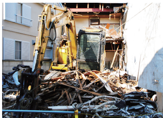
解体工事のイメージ
