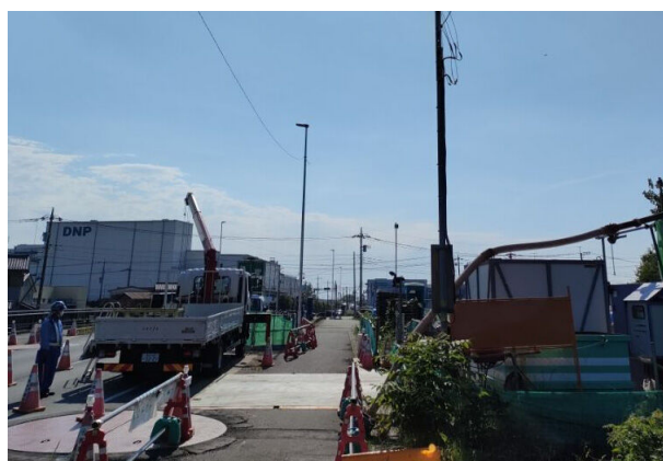
＜公共下水道工事の様子＞
