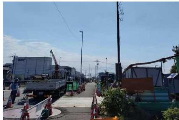
＜公共下水道工事の様子＞
