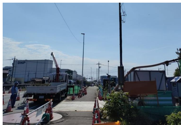
<公共下水道工事の様子>
