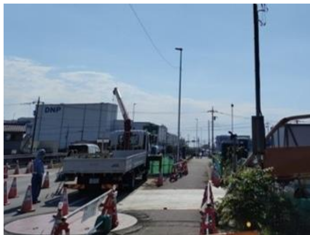
<整備が進む公共下水道>
