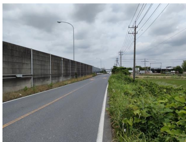
＜県道蓮田白岡久喜線（歩道未整備区間）＞
