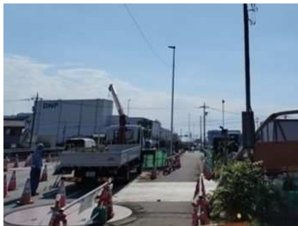
＜整備が進む公共下水道＞
