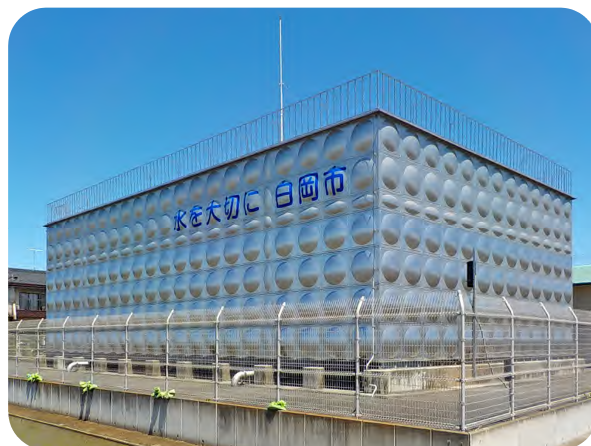
ステンレス配水池
