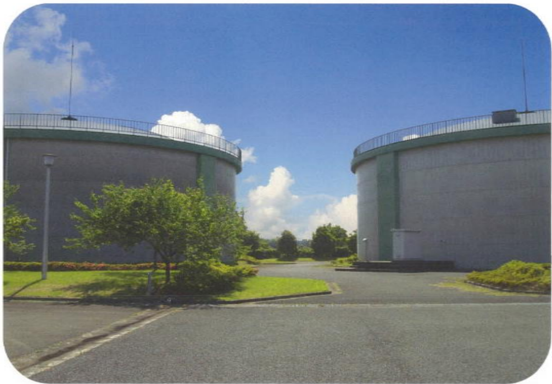
高岩浄水場（配水池）
