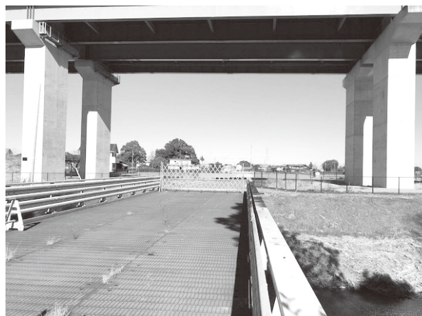
備前堀川の仮橋
