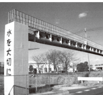
姫宮落川に架かる水管橋
