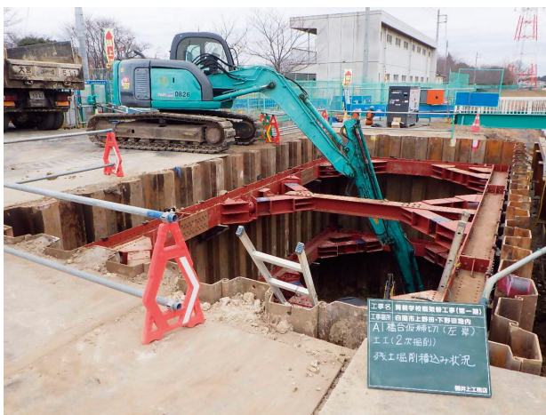
菁莪学校橋架替工事の様子
