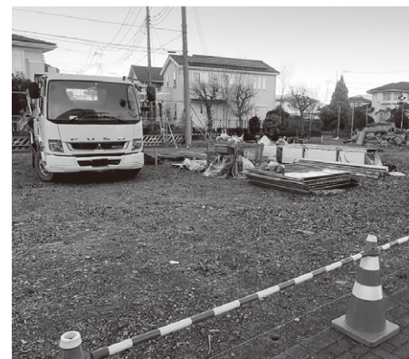
令和2年12月21日時点の建設予定地
