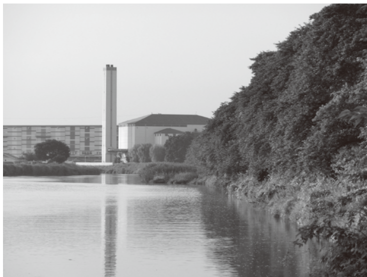
蓮田白岡衛生組合 環境センター
