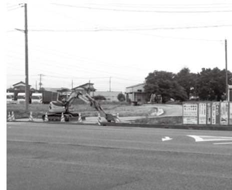
樋ノ口付近の路線断絶 (開通時期未定)
