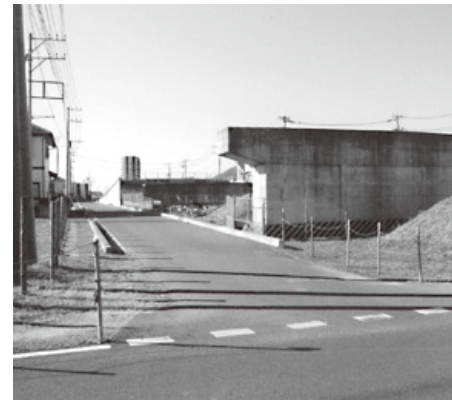
工事が進む白岡宮代線
