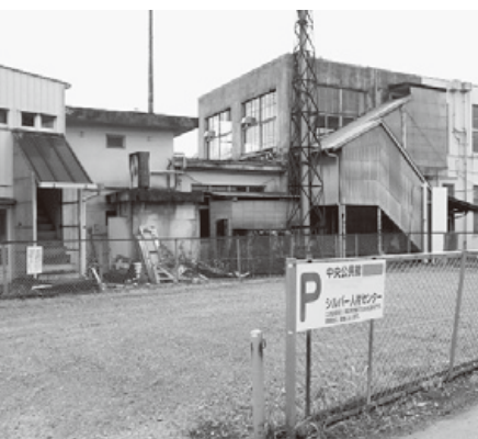
解体予定の旧庁舎
