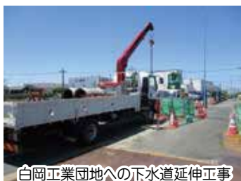
白岡工業団地への下水道延伸工事
