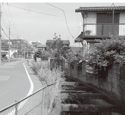
蓋掛けされていない水路
