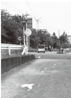
見えにくい路面標示
