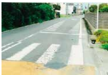
太田新井字北地内の市道
