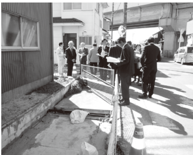
西4丁目地内の公共下水道工事現場を視察
