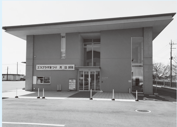
蓮田白岡衛生組合リサイクルプラザ
