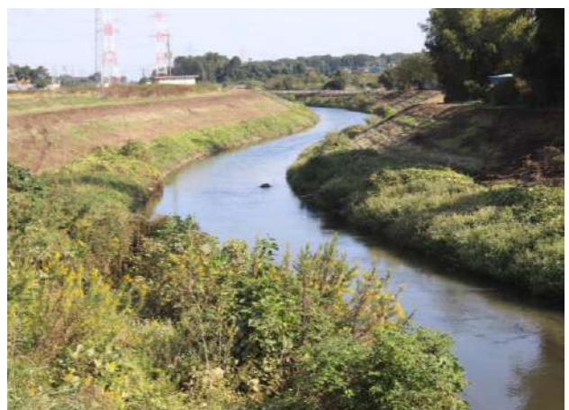
隼人堀川（六兵衛橋から）
