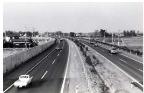
東北縦貫自動車道開通
