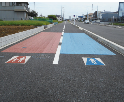
自転車専用レーンの一部
