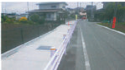
車歩道分離化の整備が行われた南小学校・天使幼稚園周辺の道路
