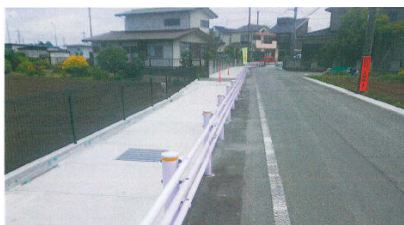
車歩道分離化の整備が行われた南小学校・天使幼稚園周辺の道路
