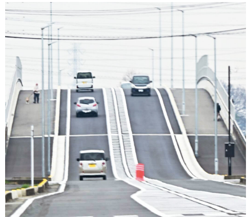
白岡中央大橋
