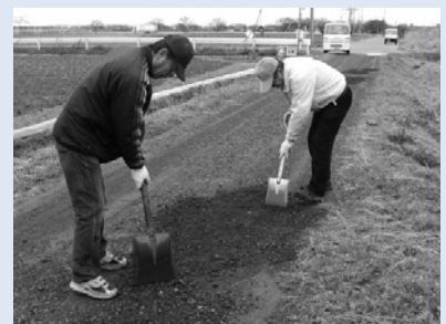
農道の路面補修
