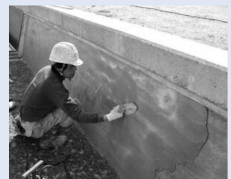
老朽化した水路壁のコーティング
