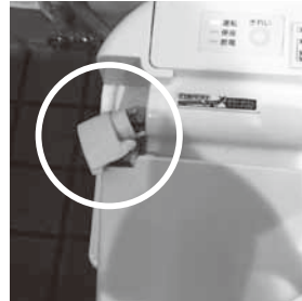
壊された便器
