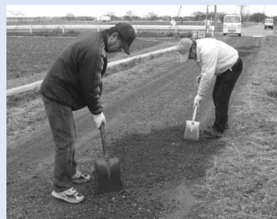
農道の路面補修
