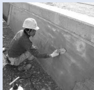
老朽化した水路壁の コーティング
