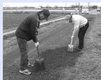
農道の路面補修
