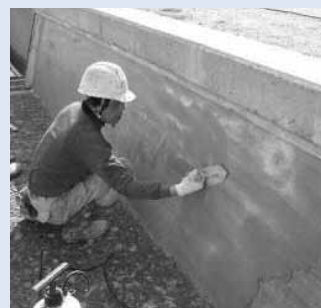
老朽化した水路壁の コーティング
