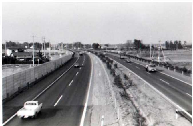
東北縦貫自動車道開通
