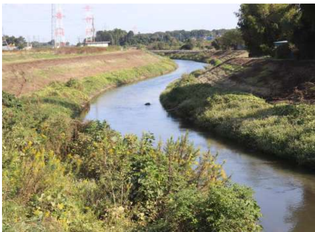
隼人堀川（六兵衛橋から）
