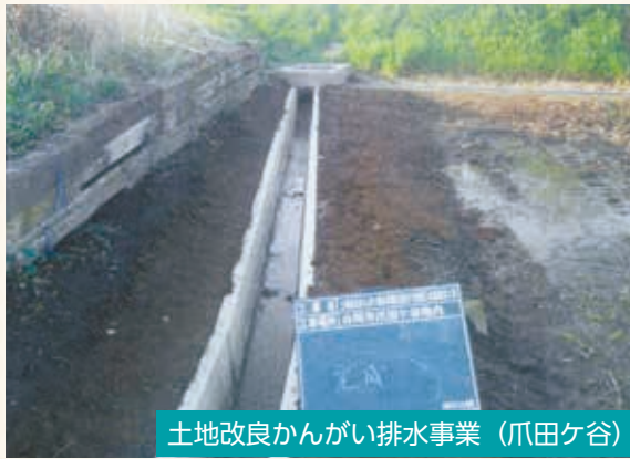
▲改修された用排水路
