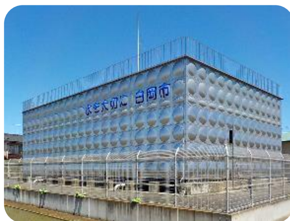
ステンレス配水池
